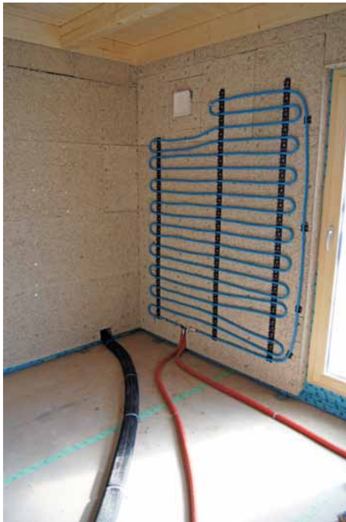
Wandflächenheizung auf Putzträger montiert, vor dem Verputzen mit Lehm. Bild: Stefan Schön
